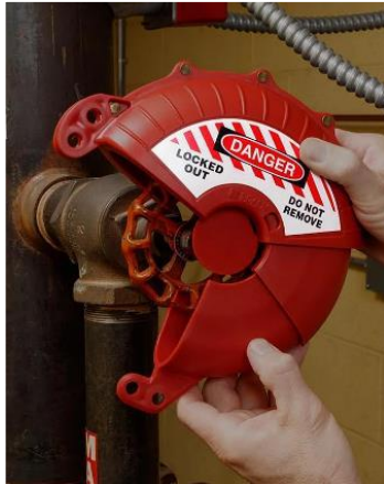
LOTOTO-materiaal voor een handwiel
