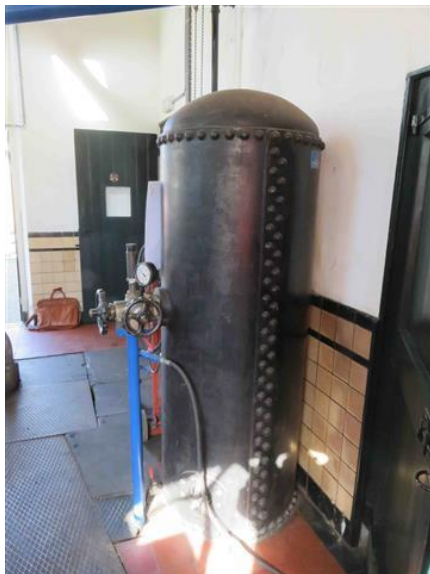
Geklonken startluchtvat
