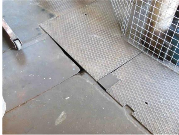
Stalen vloerplaten voor afdekking leidingengoot in het looppad
