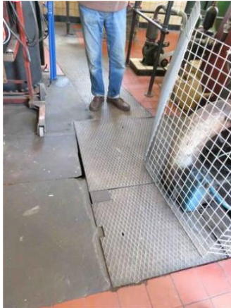
Stalen vloerplaten voor afdekking leidingengoot in het looppad
