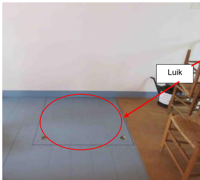
Vloeropening in kantine 1 e verdieping boven open koelwatertank
