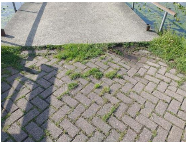
Bestrating, met lichte verzakking bij aansluiting toerit brug
