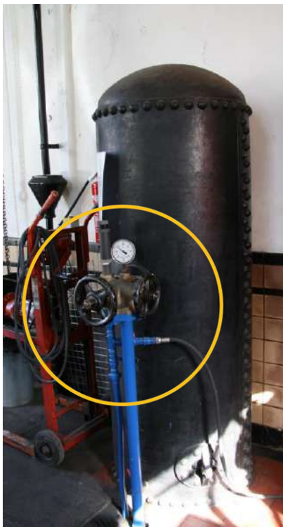
Opstelling startluchtvat en het daaraan bevestigde manifold
