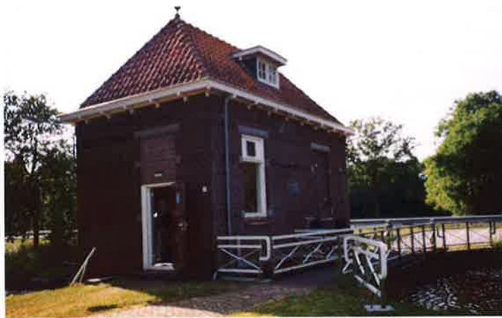
Afbeelding 1. Sluisgemaal De Gauwebrug aan de Drentse Hoofdvaart
