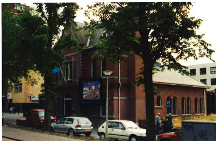
Afbeelding 2. Gemaal Westersingel te Rotterdam. Vroeger een boezemgemaal met een door middel van een stoommachine aangedreven zuigerpomp. Het gebouw huisvest nu een rioolgemaal.
