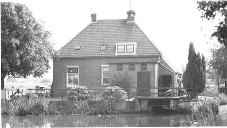
Afbeelding 4. De combinatie van een elektromotor en hergebruikt scheprad bij het gemaal Timmer te Giessenburg
