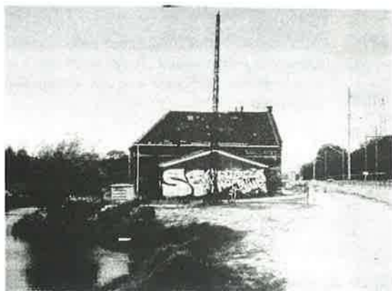
Afbeelding 60. Een landschappelijk verpeste situatie: gemaal De Vereeniging. De trein die hier met een hoge frequentie voorbij raast reduceert de hergebruiksmogelijkheden aanzienlijk. Aanwezig is nog de seinmast en als klein hokje zichtbaar, de automatische gemaalrichting.
