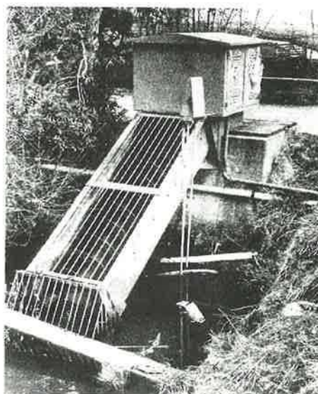
Afbeelding 25. Een kleine automatische vijzelinrichting zoals deze vaak aangetroffen kan worden.
