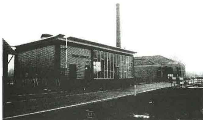
Afbeelding 64. Gemaal 'Veneriete' met op de achtergrond gemaal 'Mastenbroek'.
