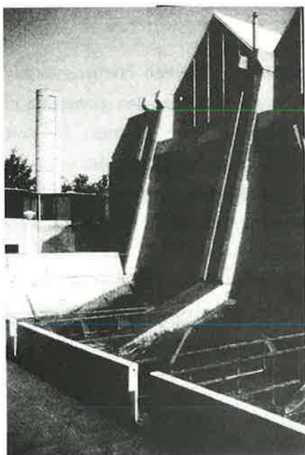
Afbeelding 63. Gemaal 'Halfweg': een modern gemaal met een "antieke" vorm van opvoerteknik.
